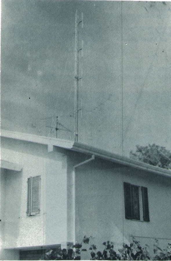
Antenna co-lineare a quattro dipoli. Si noti a destra la cinque elementi yagi polarizzata orizzontalmente, destinata ai collegamenti fra gli studi « alpha » e « beta ».
